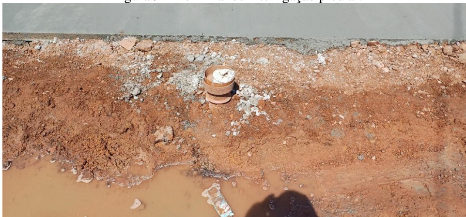
Figura 94- Terminal de interligação predial.
