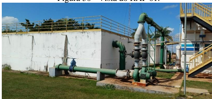
Figura 50 - Vista do RAP 01.
