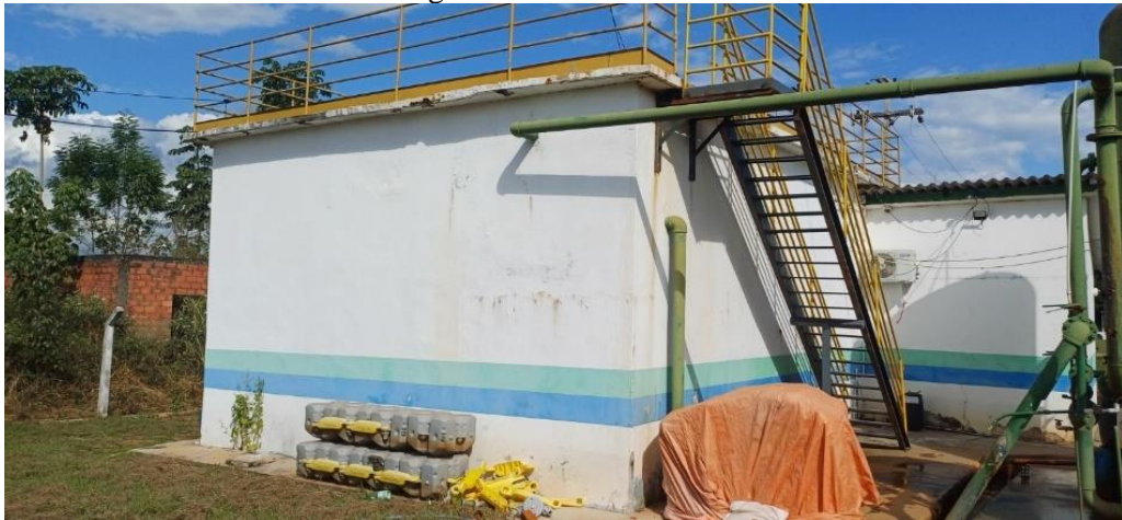
Figura 72- Vista do RAP.
