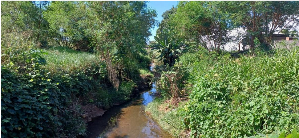
Figura 111 – Vista do Canal 5 cruzando a Quadra 55, próximo a Av. Manaus.
