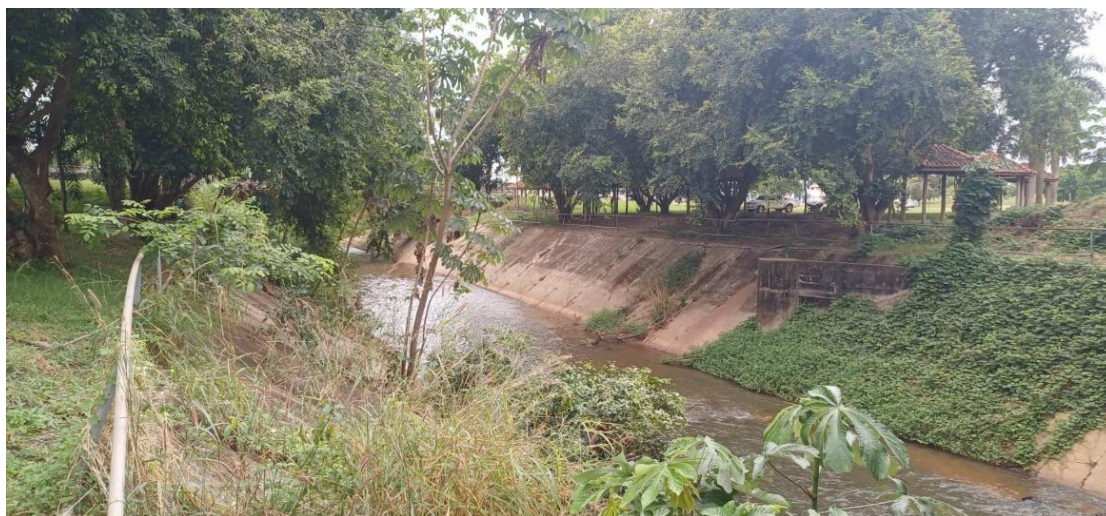
Figura 99 – Rio Anta Atirada com retificação de concreto na Av. 25 de Agosto.
