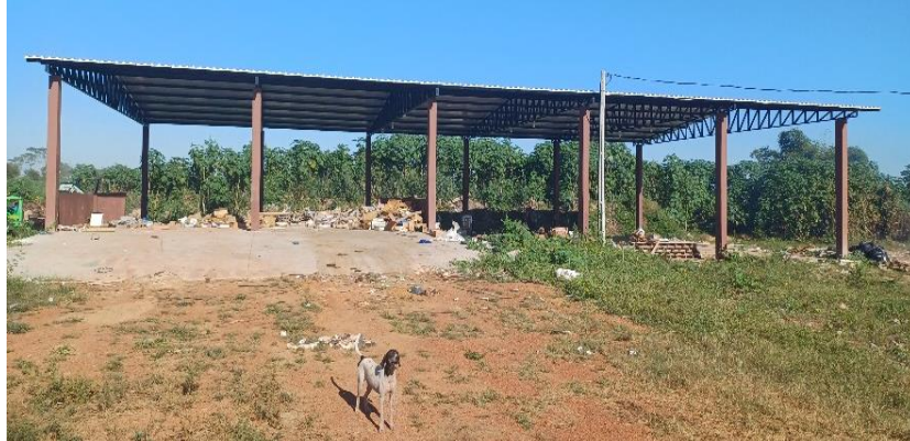
Figura 165- Vista do barracão de triagem construído pela SANEROM.
