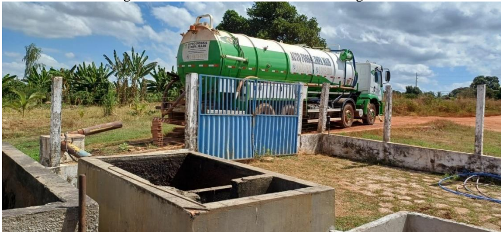
Figura 90- Caminhão auto fossa descarregando.
