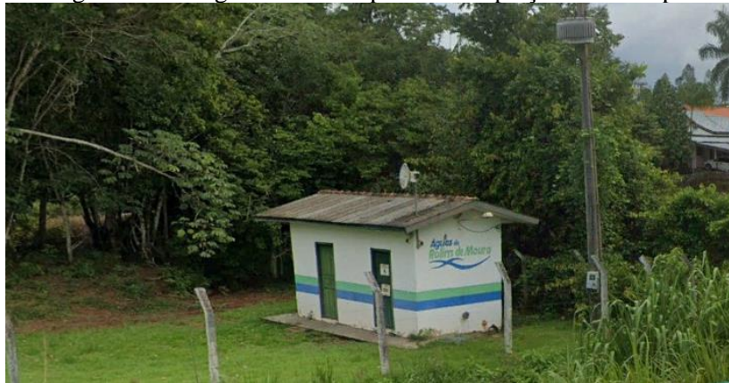
Figura 65- Abrigo onde fica o painel da captação do rio Cipó.
