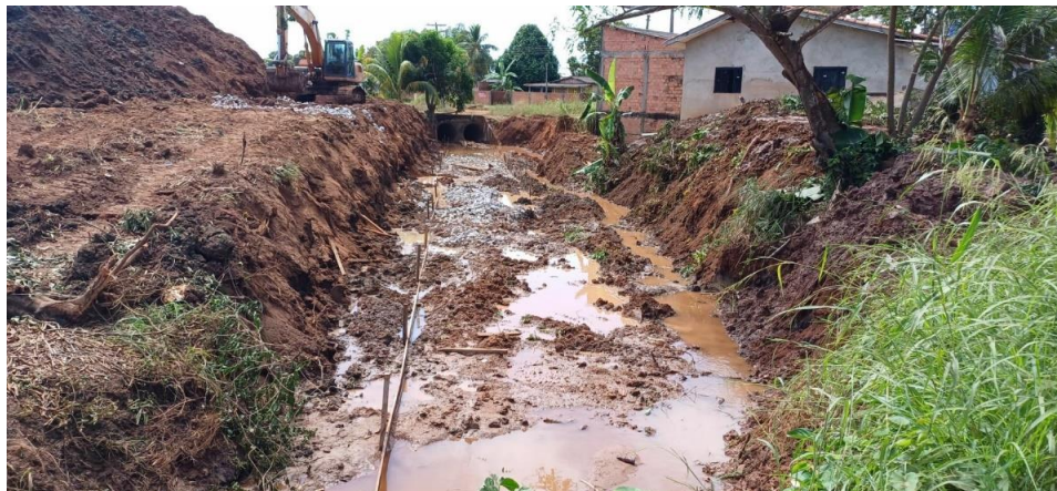
Figura 108 – Obra de canalização do Canal 4.
