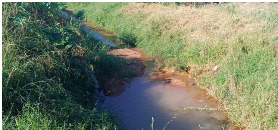
Figura 124 – Vista do Canal 7, próximo a Travessa dos Parecis.
