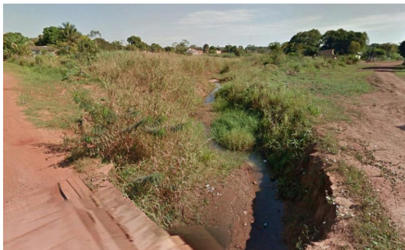
Figura 137 – Vista do canal 13, cruzando a Av. Natal.
