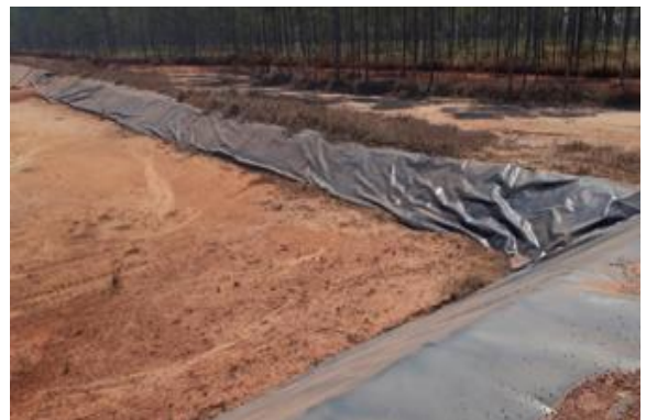
Sistema de drenagem de gás e de líquido percolado (Chorume)
