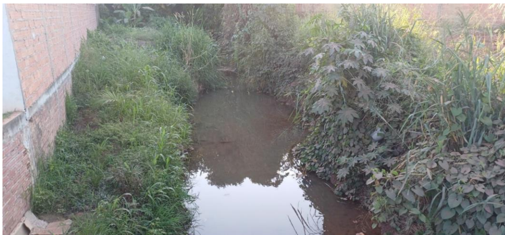
Figura 135 – Ocupação da APP do Canal 11 próximo à R. Guaporé, formada por capins e imóveis.
