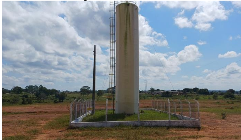
Figura 52 - Vista do REL.
