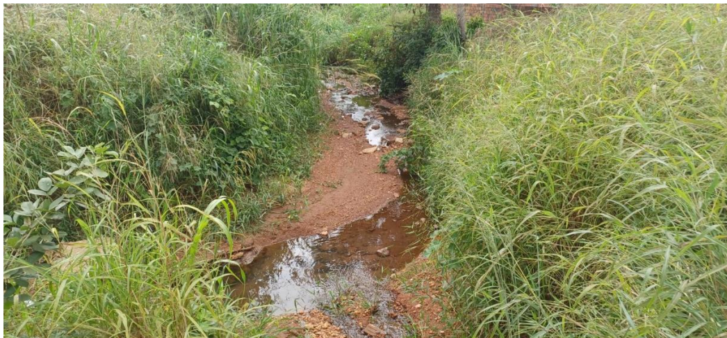
Figura 102 – Vista do Canal 2 na Avenida 7 de Setembro.
