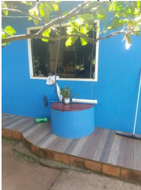
Figura 77 - Poço amazonas em propriedade rural.
