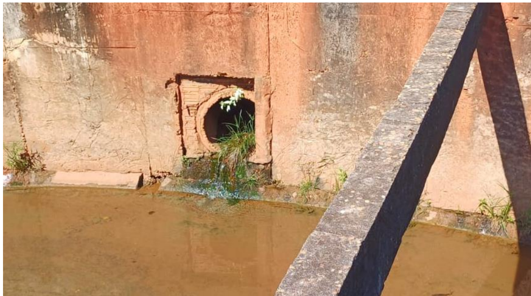
Figura 151 – Lançamento de águas pluviais na macrodrenagem canalizada.
