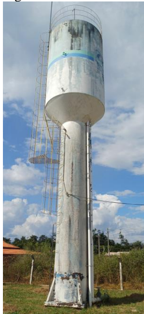
Figura 73- Vista do REL.
