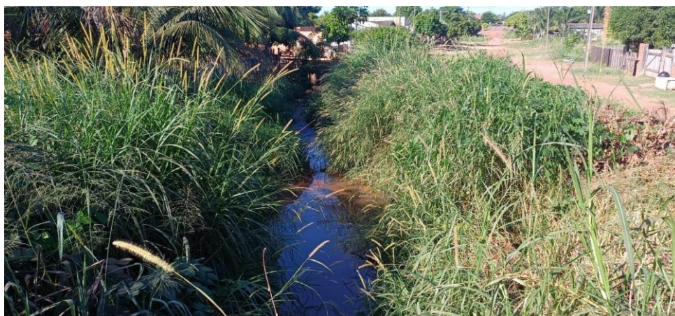
Figura 127 – APP do Canal 7 próximo à Rua Ouro Preto.
