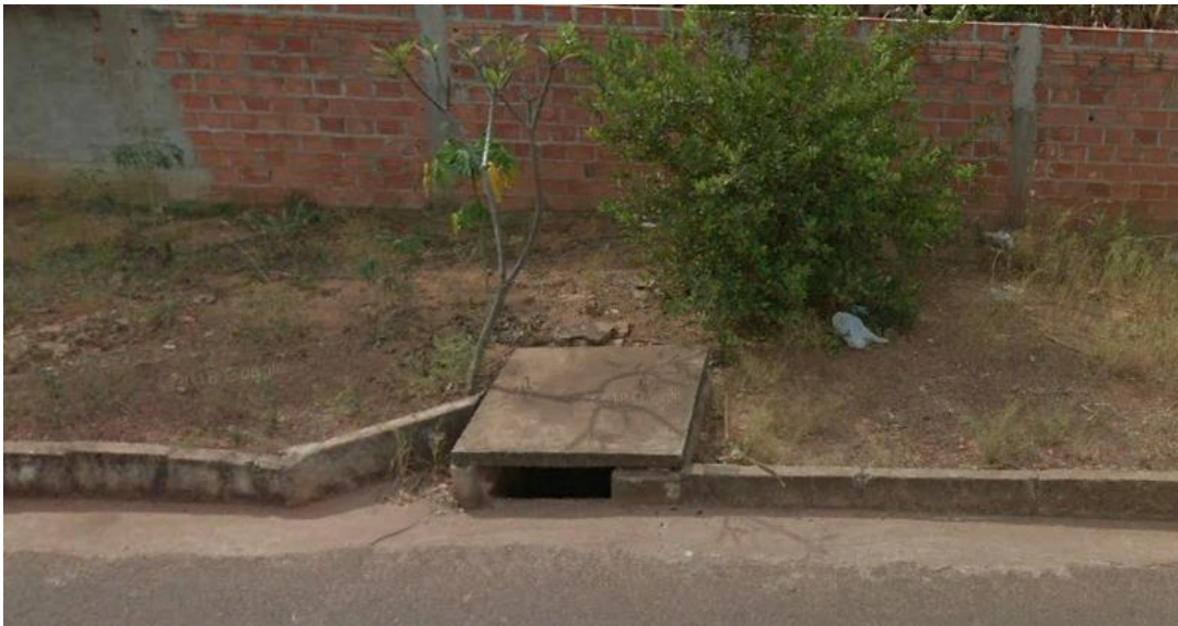
Figura 149 – Boca de lobo de guia, na Av. Fortaleza.
