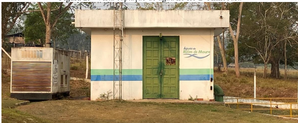
Figura 29- Vista captação de água no rio D'Alincourt.
