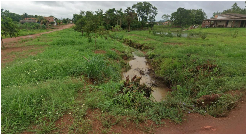
Figura 104 – Vista do Canal 3 na Rua Brasforest.
