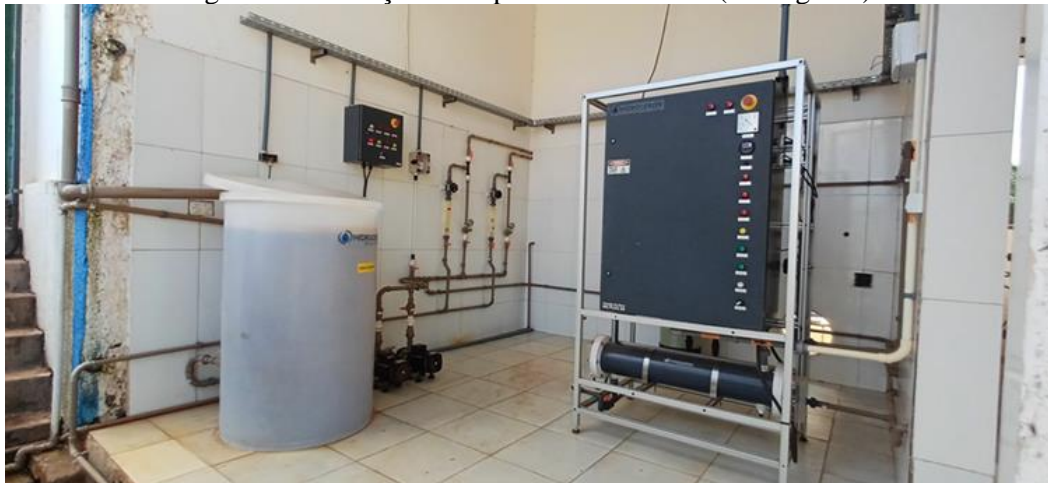
Figura 47- Produção de Hipoclorito de Sódio (Hidrogenon).
