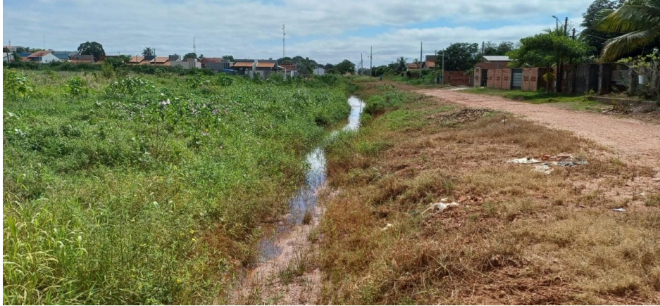
Figura 106 – Vista do Canal 4 margeando a Rua Corumbiara.
