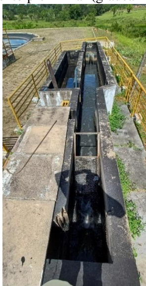
Figura 81 - Tratamento preliminar (gradeamento e desarenador).
