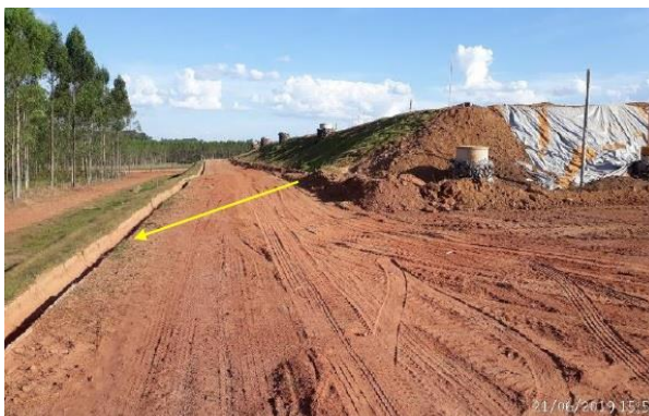
Sistema de drenagem de águas superficiais
