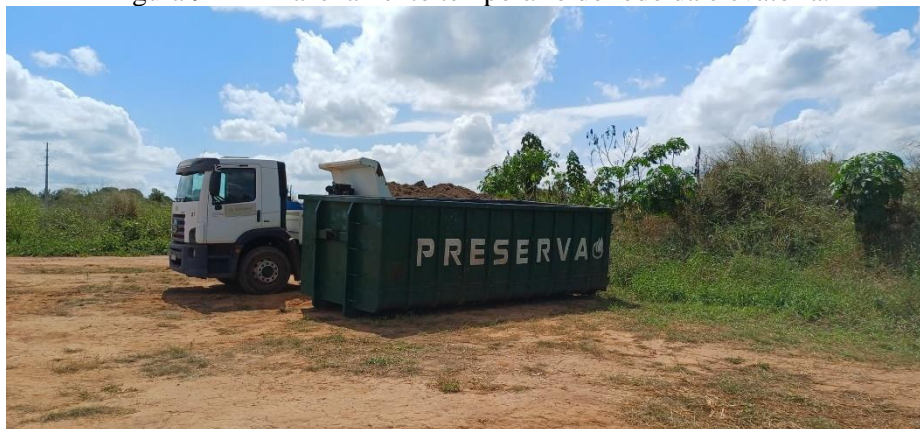
Figura 92- Armazenamento temporário do lodo da elevatória.
