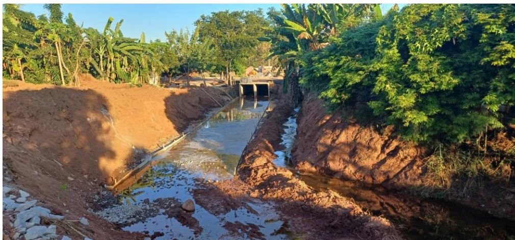
Figura 134 – Trecho em obra de canalização do Canal 11 próximo a Av. Belém.
