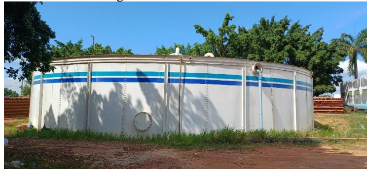
Figura 51- Vista do RAP 03.
