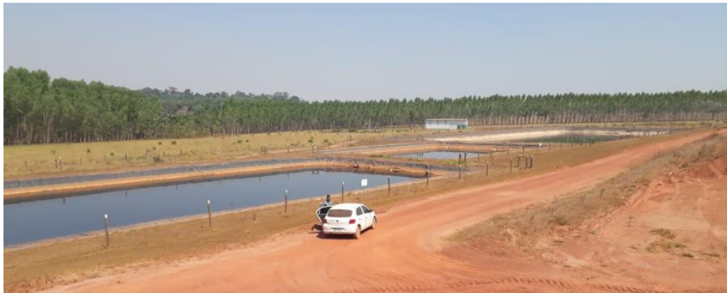
Figura 164- Lagoas de estabilização utilizadas no tratamento biológico de lixiviados do aterro sanitário.
