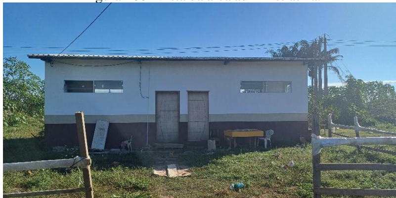
Figura 166- Vista da área administrativa.
