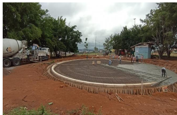
Fonte: Acervo próprio – Construção da base para reservatório. Foto 7 e 8
