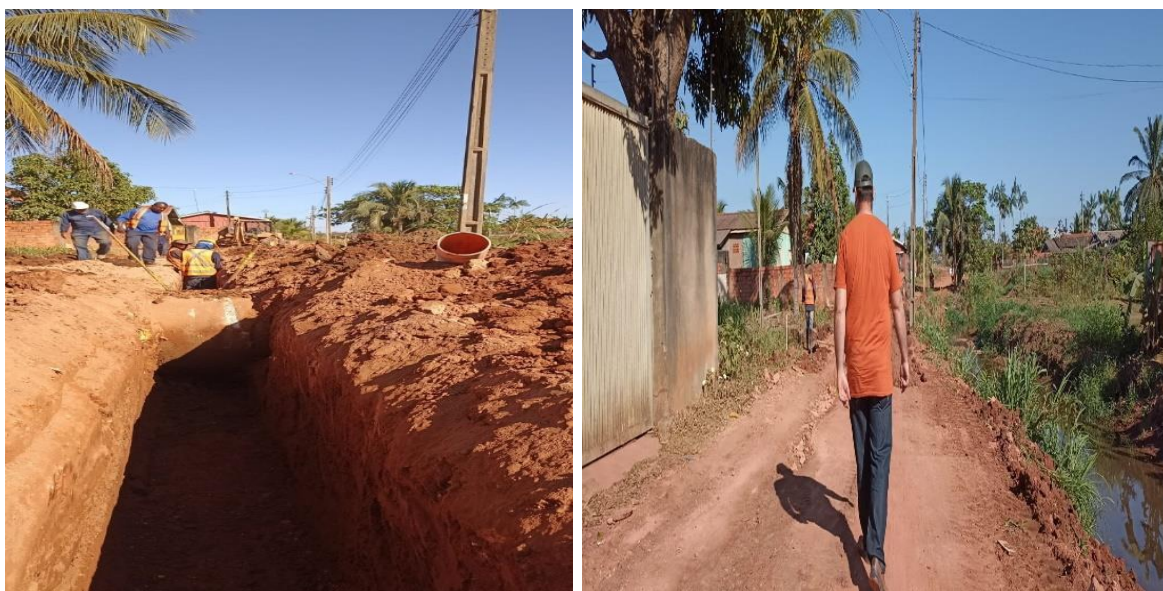
Fonte: Acervo próprio – Ampliação da rede de esgoto. Fotos 16 e 17.
