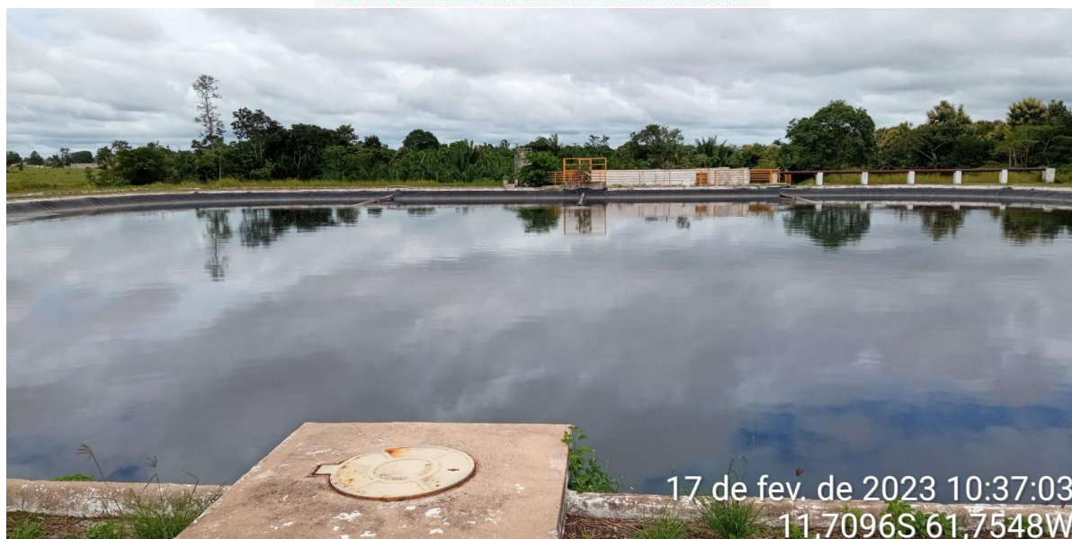
Fotos 13 e 14: Fiscalização na Estação de Tratamento de Esgoto.
