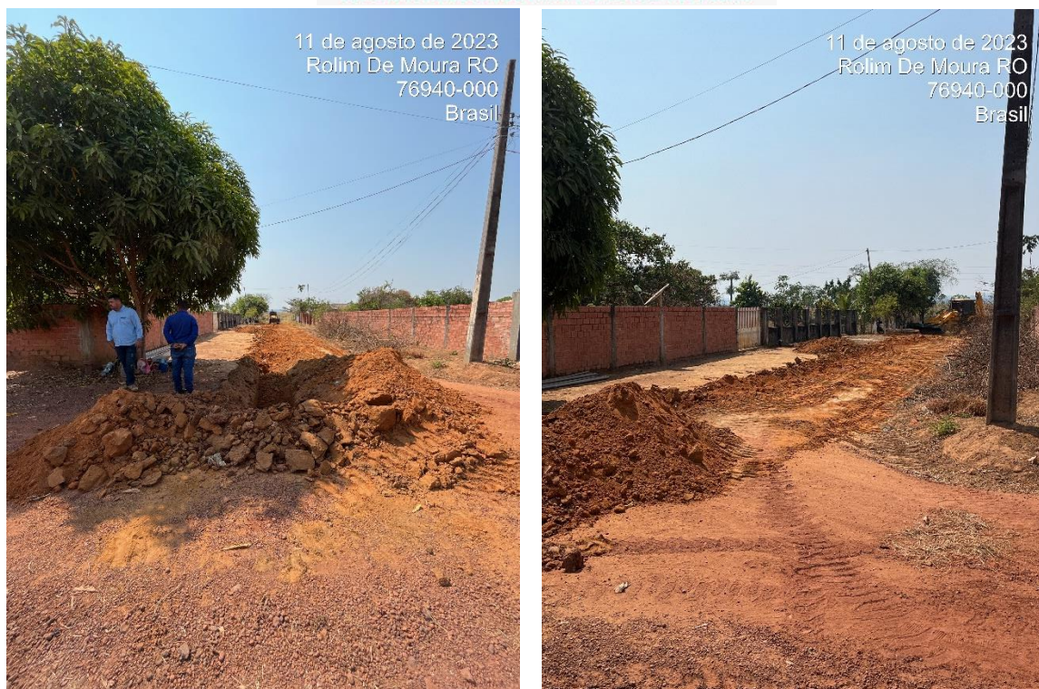
Fotos 15 e 16: Acompanhamento das obras de expansão da rede de água Tratada na Vila Celestino.
