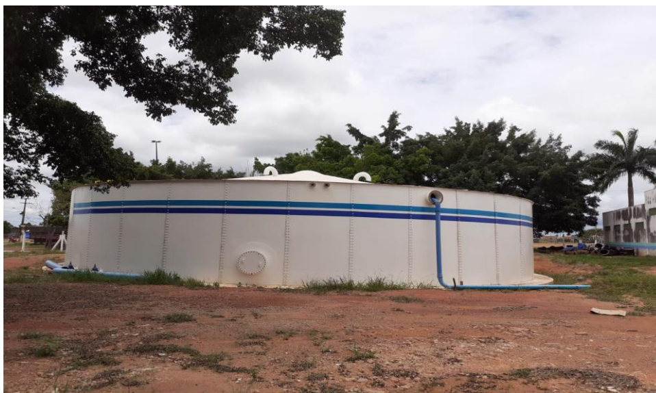
Foto 19: Reservatório de água finalizado
