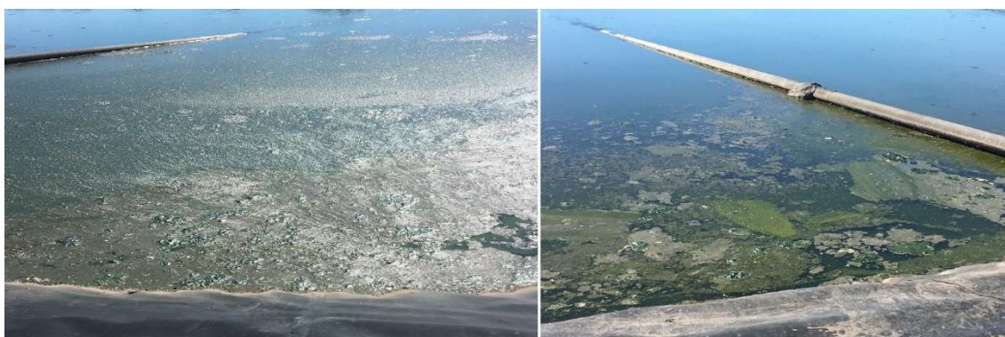
Fonte: Acervo próprio – Excesso de lodo nas lagoas de decantação - Antes – fotos 10 e 11
