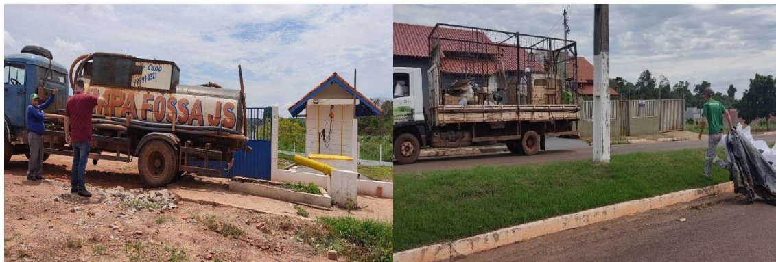
Fonte: Acervo próprio fotos 08 e 09 – Fiscalização EEE (Estação elevatória esgoto) e fiscalização do projeto piloto da coleta seletiva bairro jequitibá.
