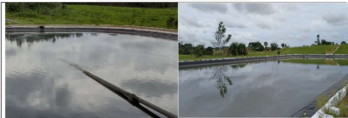
Fonte: Acervo próprio – Excesso de lodo nas lagoas de decantação - Depois – fotos 12 e 13
